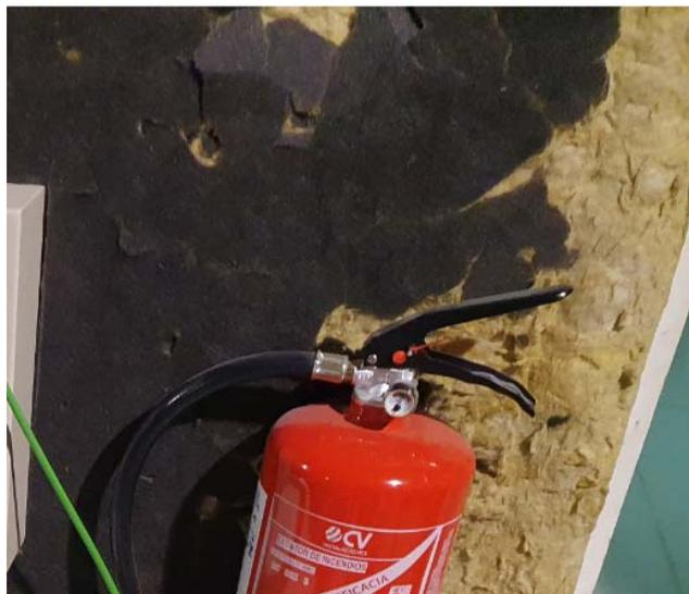
El cerramientos exteriores de fachada del espacio del Vestíbulo de Planta Baja, está conformado por fábrica de ladrillo cerámico hueco doble de ½ pie de espesor, revestido exteriormente por placa de metálica de acero cortén, enfoscado interiormente, con mortero de cemento y arena de río, cámara de aire de 5 cm. Asilamiento de poliuretano proyectado de 30 mm y tabicón de ladrillo cerámico hueco doble 24x11,5x7 cm., recibido pasta de yeso.
